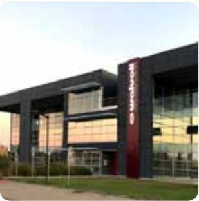
Galtech Site Cavriago (RE) • Italy
